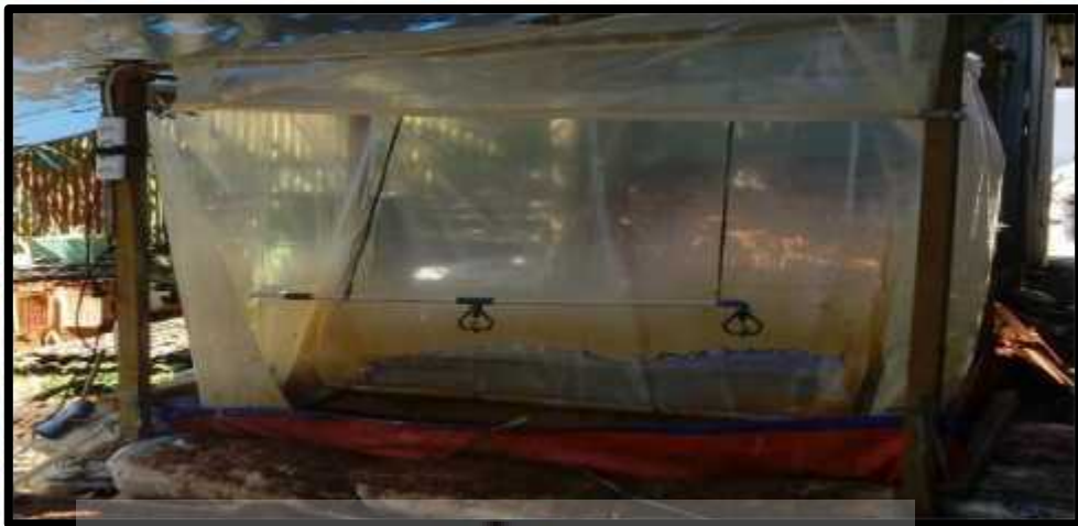
Gambar 2.4. Instalasi Pengolahan Bijih Emas Heap leaching saat Instalasi.
